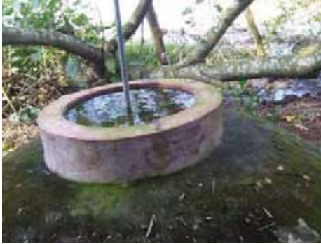
Bể Biogas để xử lý chất thải lỏng.
