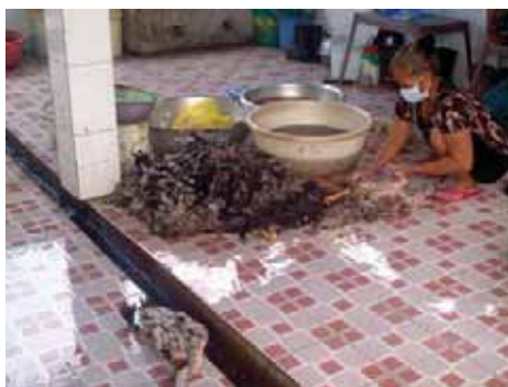
Rãnh thoát nước ở một khu vực giết mổ. Rãnh này cần phải được làm sạch thường xuyên để loại bỏ các chất thải rắn.
