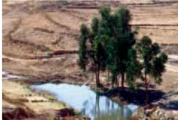
6. Collecte des eaux de ruissellement en Erythrée: petit barrage.
