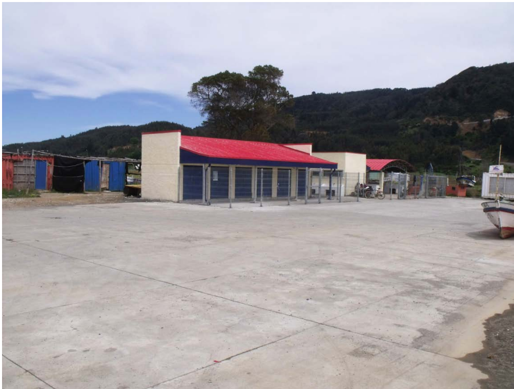
Figura 32. Infraestructura principal caleta de Llico.
