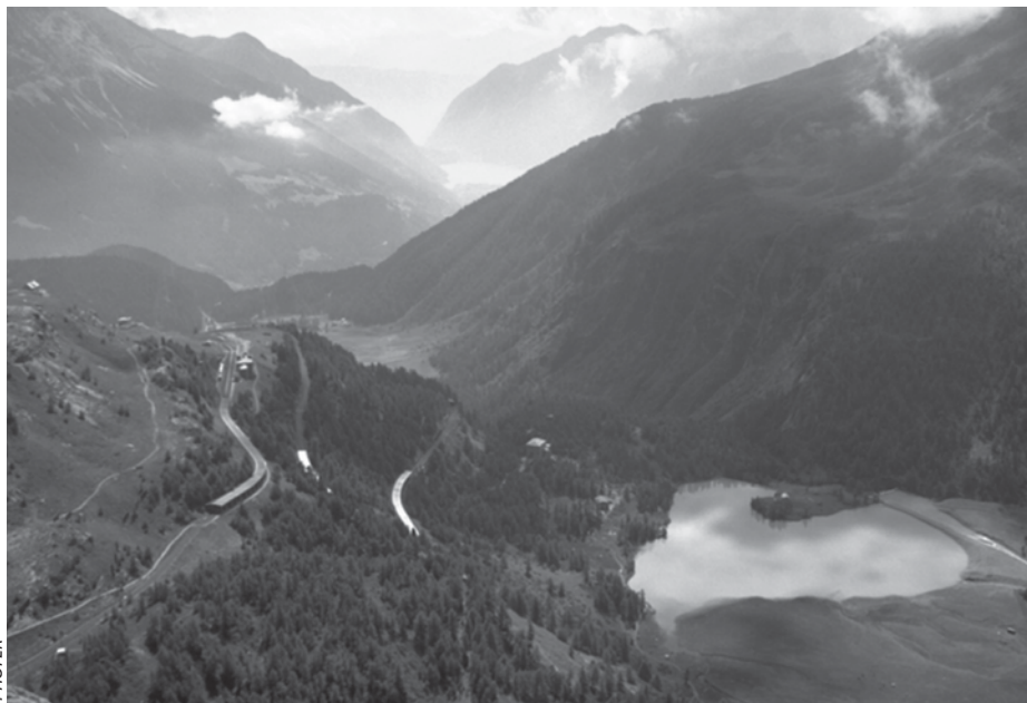
Una franja forestal protege una central hidroeléctrica y las vías férreas transalpinas de posibles aludes (Suiza)
