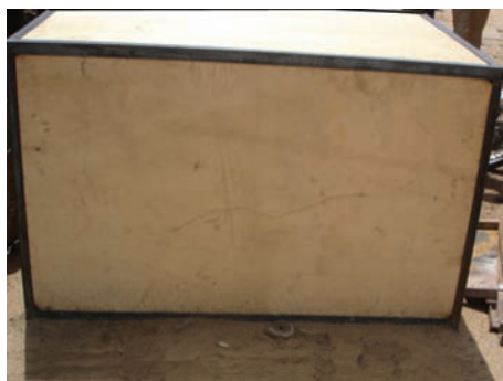
PHOTO 10 Fixation des panneaux par des cornières en fer
