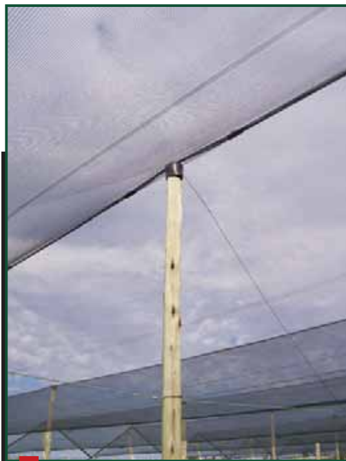
Foto 7.4. Vista del sombrero plástico colocado sobre el poste.
