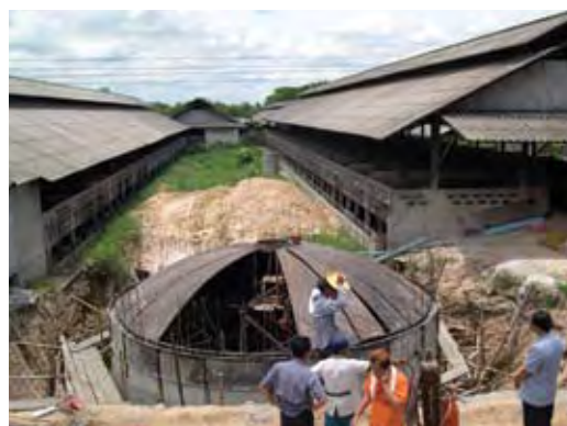
Digestor anaeróbico para la producción de biogás en una granja porcina comercial (Tailandia central, 2005)
