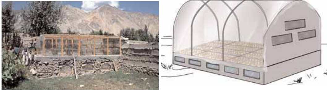
۲۹م شکل: یو ډول لمريز د وچولو ماشین چې دیوالونه یې له خټې څخه جوړ شوي دي.
