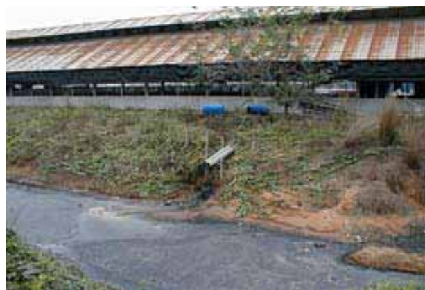
Lagune d'épuration dans un élevage de porcs – centre de la Thaïlande 2000
