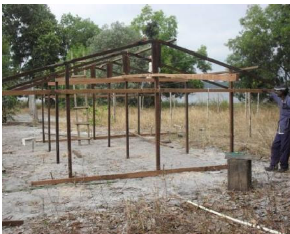
Image 1 : Le squelette d'un hangar
