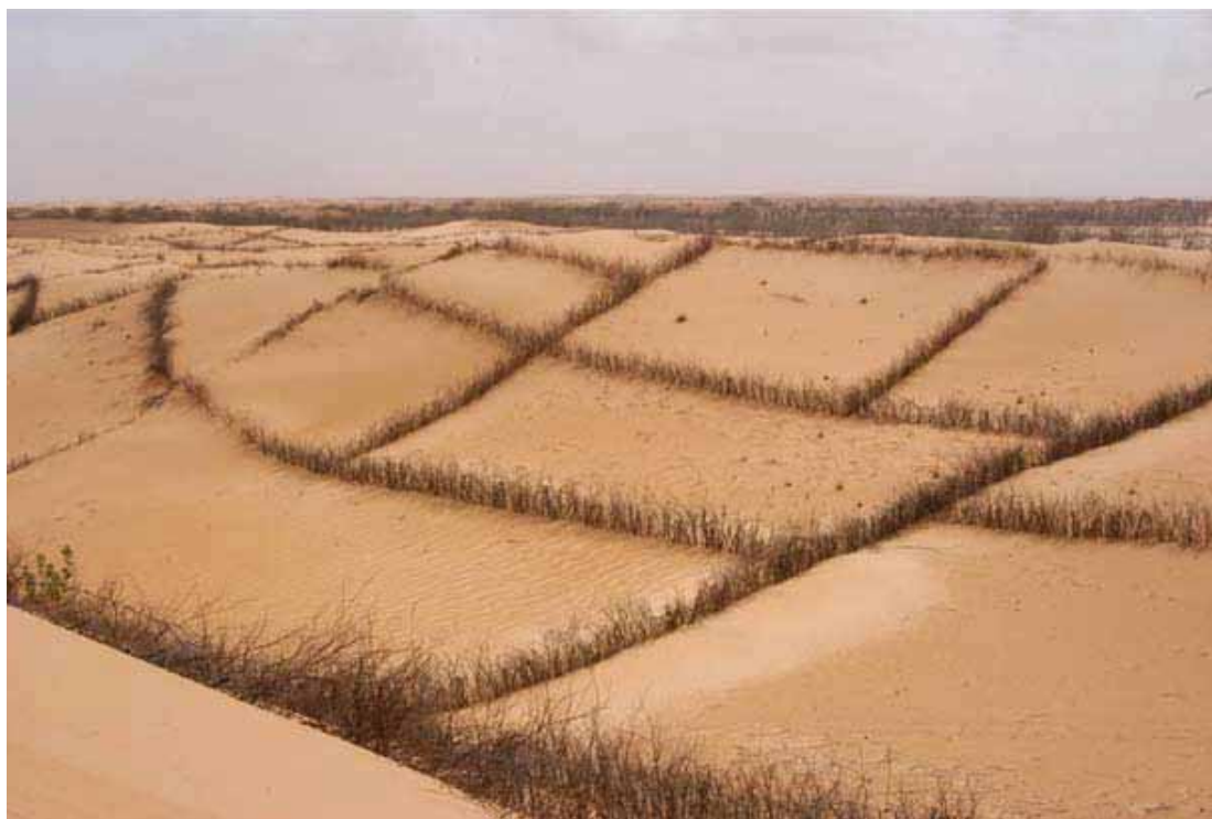
Photo 2 : Fixation mécanique constituée en Mauritanie par un carroyage de barrières réalisées à l'aide de branchages de Prosopis sp. (Projet d'appui à la réhabilitation et à l'extension de la ceinture verte de Nouakchott)
