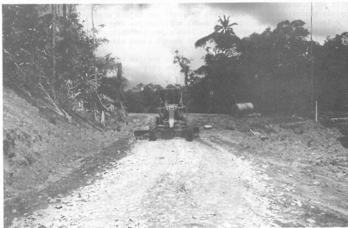
Entretien d'une route principale à la niveleuse automobile
