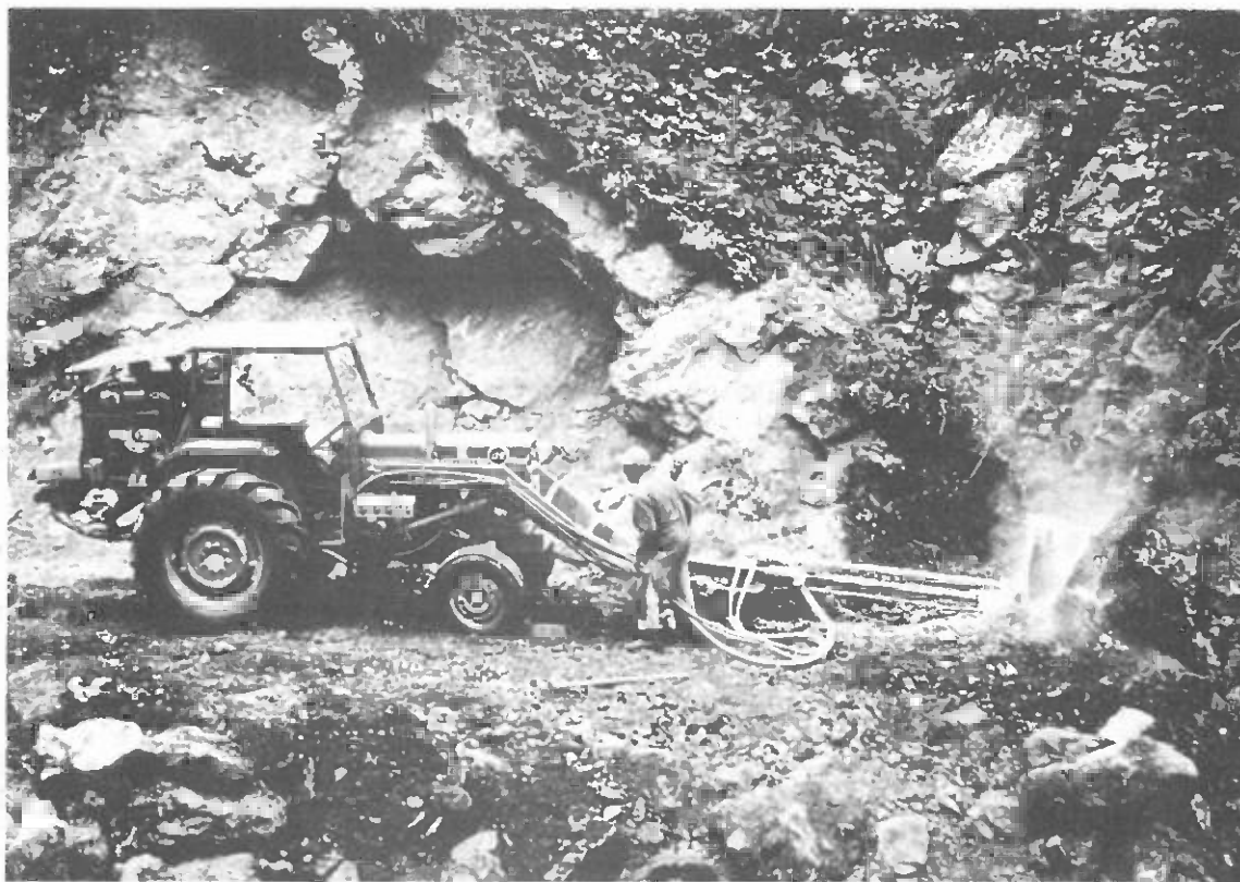
Forage mécanisé des trous de mines en terrain rocheux de montagne
