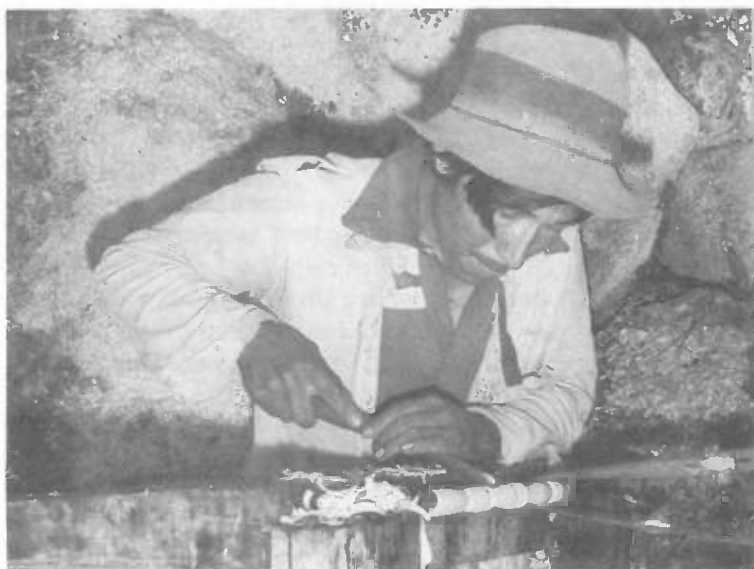
Torneado de una pata de silla en un taller rural de la comunidad
