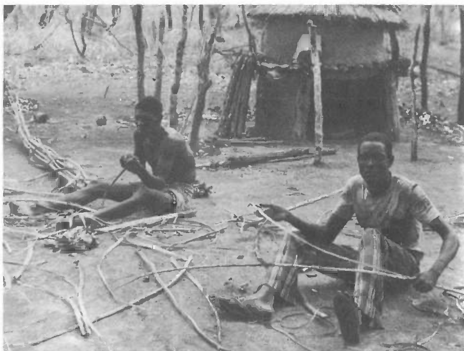
Arrancando la corteza de Grewia mollis - usado para atar listones para techos de vivienda.
