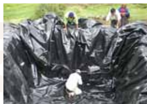
Construcción de pozo de agua
