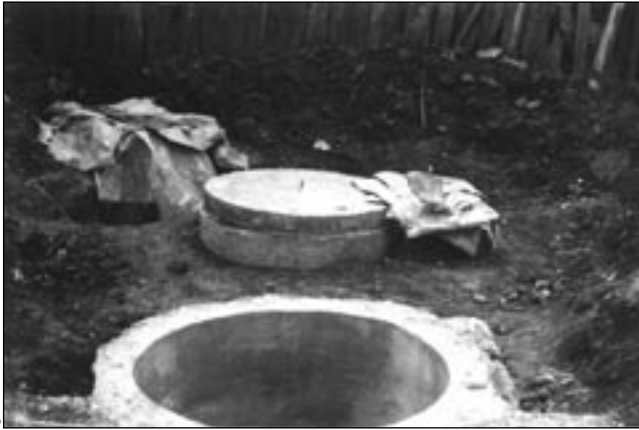
Entre los beneficios derivados de los proyectos de gestión conjunta en la provincia de Yunnan están la construcción de depósitos de biogás (en la imagen) y la introducción de estufas y fogones de biogás como solución para la escasez de leña
