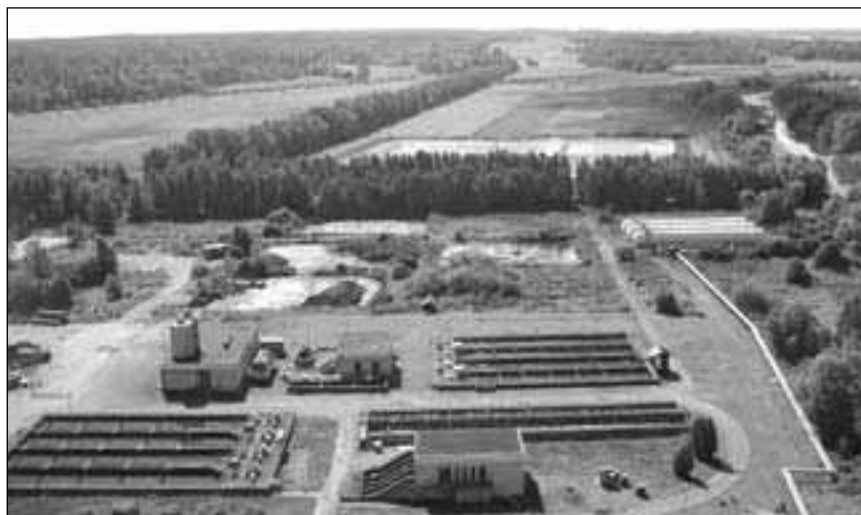
Sistema de fitorremediación mediante plantación de 75 hectáreas de sauces en Enköping, Suecia central: planta de tratamiento de aguas residuales (primer plano), albercas para almacenar las aguas en invierno (al fondo) y campos de sauces regados con efluentes de fangos
