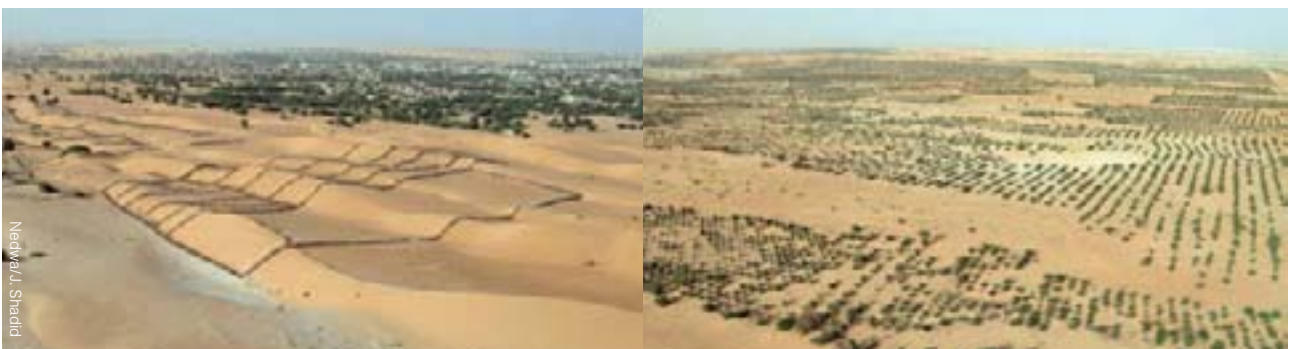
Cinturón verde a las afueras de Nouakchott, Mauritania, para proteger la ciudad del avance de las dunas de arena. A la izquierda, la fijación mecánica de dunas de arena precede a la plantación de árboles; a la derecha, rodales de protección ya establecidos (2005)
