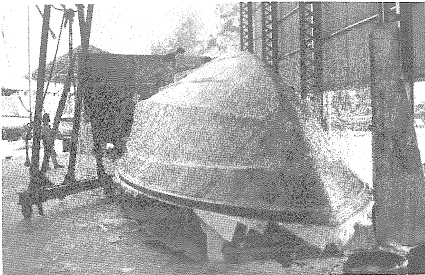
Figura 26 Construcción del molde
