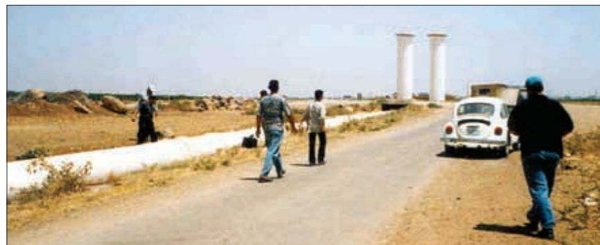
Projet du Old Alyarmook, Alyarmook Basin, système de transport d'eau de la Syrie méridionale après modernisation (système de canalisations sous pression).
