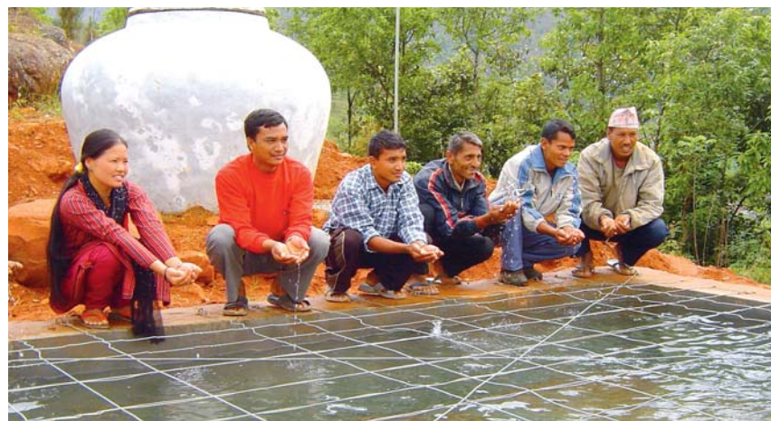
Association d'une cuve thaïlandaise et d'un réservoir d'eau souterrain dans un projet MUS, au Népal.
