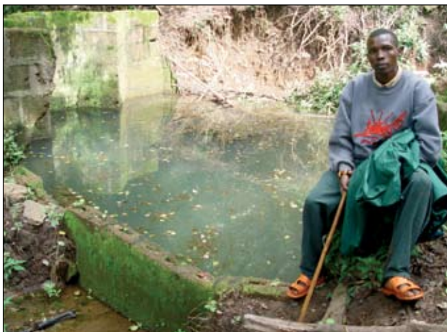
Un bassin de retenue construit il y a environ 30 ans recueille l'eau de source du mont Kulal et la canalise vers les réservoirs d'eau qui alimentent les communautés locales
