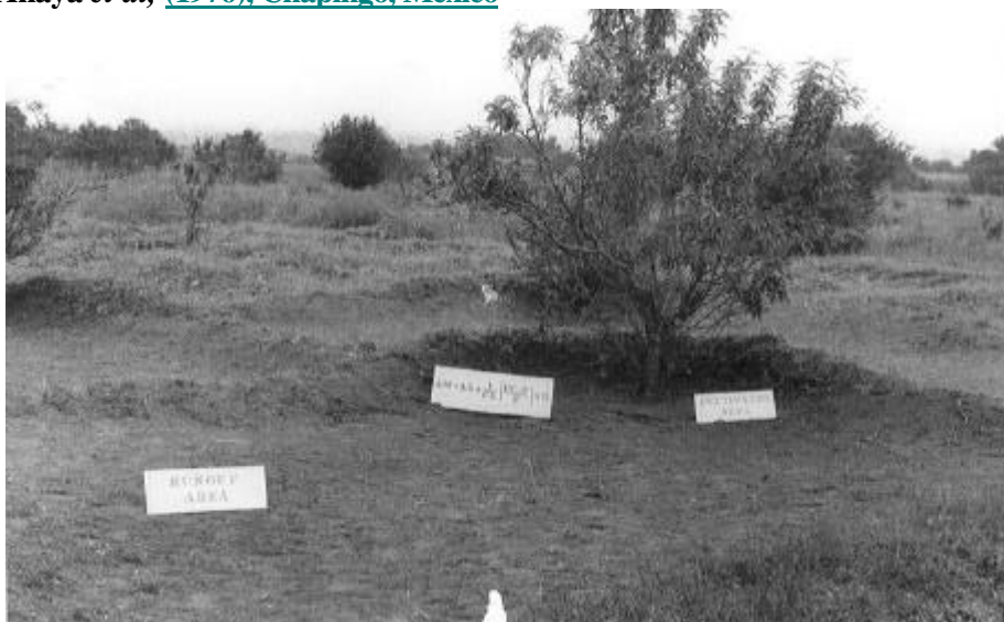
Figura 8. Vista del tamaño de microcaptaciones para frutales calculadas mediante la fórmula de Anaya et al , (1976), Chapingo, México
