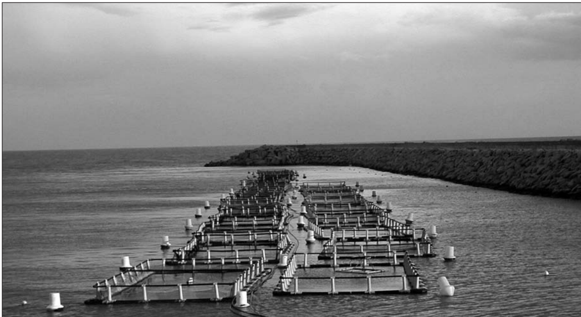
illustration 7 Cage rectangulaire en HDPE. Construite par le pisciculteur lui-même, Licata.
