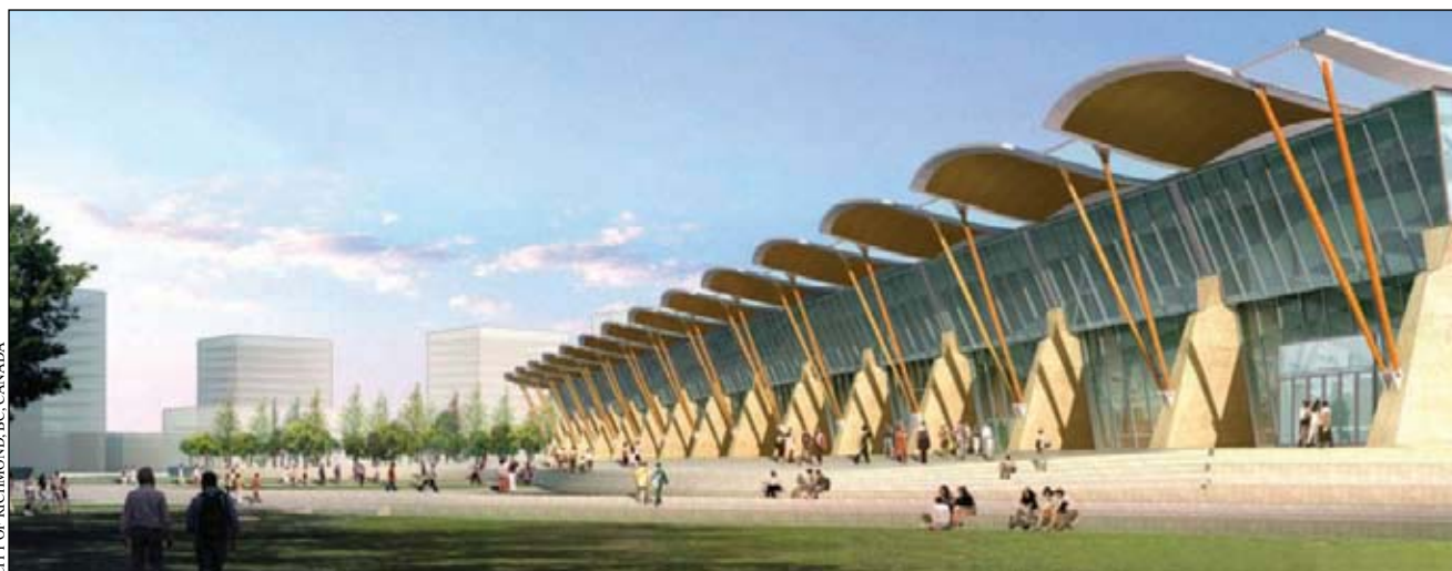
La Colombie-Britannique encourage l'emploi du bois dans la construction – le toit de 2,6 ha de l'Anneau olympique de patinage de vitesse de 2010, bâti près de Vancouver pour les Jeux olympiques d'hiver de 2010, est construit principalement avec le bois d'arbres tués par le dendroctone du pin
