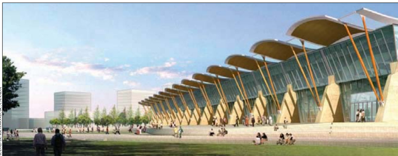
Columbia Británica está impulsando la utilización de la madera para la construcción: en las cercanías de Vancouver, el techo del óvalo olímpico de patinaje veloz para los Juegos Olímpicos Invernales, de una superficie de 2,6 ha, ha sido construido principalmente con madera proveniente de árboles que murieron tras el ataque de escarabajo del pino de montaña
