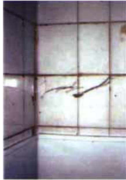
صورة 10.4 تجلب : البلاط المتصدع : يمكن أن يوفر ملجأ للكائنات الدقيقة
