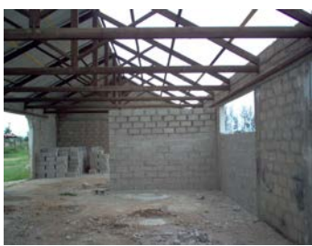
Se construyeron divisiones internas para separar diferentes compartimientos en el almacén.
