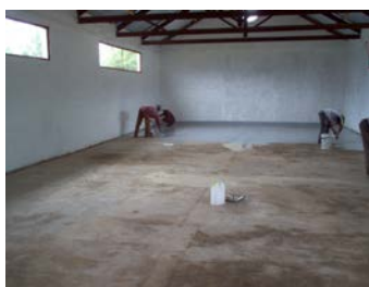
Se puso un nuevo piso de concreto sellado con resina epoxy resistente a productos químicos.
