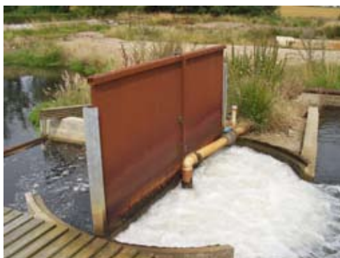
Иллюстрация 2.12 Система с аэрационным колодцем.
