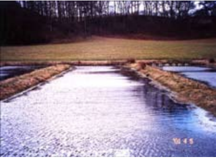
Иллюстрация 6.3 Водоочистной пруд с растениями, расположенный после УЗВ для выращивания форели в Дании – до и после зарастания. Источник: Пер Боубьерг, DTU Aqua
