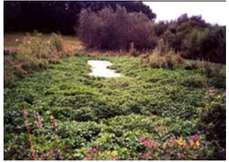
Иллюстрация 6.3 Водоочистной пруд с растениями, расположенный после УЗВ для выращивания форели в Дании – до и после зарастания. Источник: Пер Боубьерг, DTU Aqua
