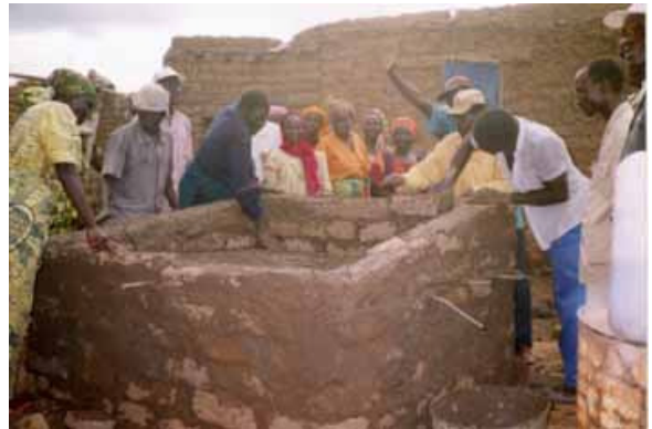
Les participants à un atelier de formation construisent un four Chorkor à Apibase (Tchad)
