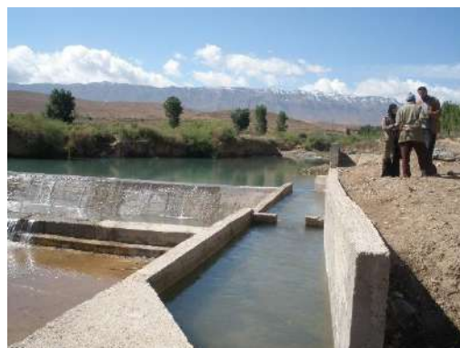
Situation après la construction du barrage par la DPA.
