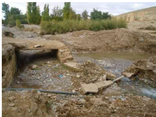
Pont de Barram avant sa construction : Visite des représentants des institutions pour étudier l'opportunité de sa reconstruction.
