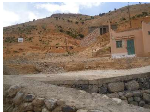
Le ravin de Bouhallouch en amont du Douar Tatiouine après son traitement antiérosif.
