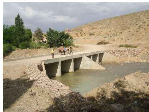
Recherche/action mise en œuvre : pont de Barram reconstruit (financé par le Conseil Régional).
