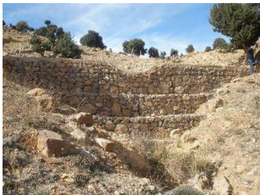
Seuil antiérosif construit en gabion sur le ravin de Bel-Lahcen.
