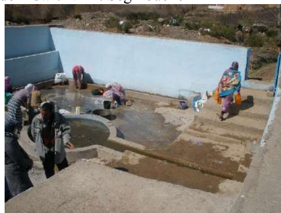
Source de Tiswit N'Ait Séghrouchen après son aménagement dans le cadre du Projet FAO/GCP/INT/093/SPA
