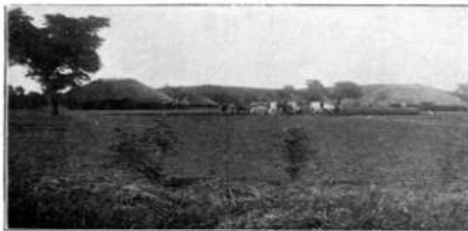
KOULICORO — LES CONSTRUCTIONS ET LE TROUPEAU DE BELLES BÂTISSES AUX TOITS DE CHUPE
