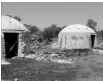
Production traditionnelle améliorée de charbon de bois: un four en brique de type brésilien à Cuba
